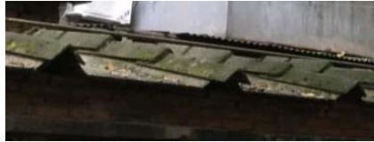
水泥折板屋顶 Cement folding roof
